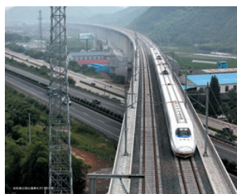
■ 高铁驶过甬台温奉化方门特大桥 (市文化馆提供)
